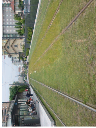
Figure 54 : Evitement asymétrique à la station Lea « Gare de Villeurbanne» (3 voies/2 quais)
