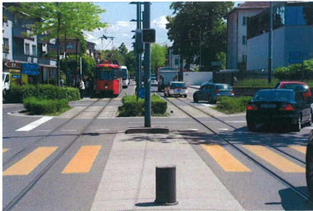
Vue de la chaussée partagée avec le tram et du rond-point traversant pour tram
